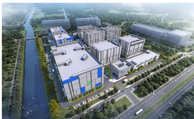
图 29：公司世纪互联新建太谷国际车联网大数据产业园二期项目案例
